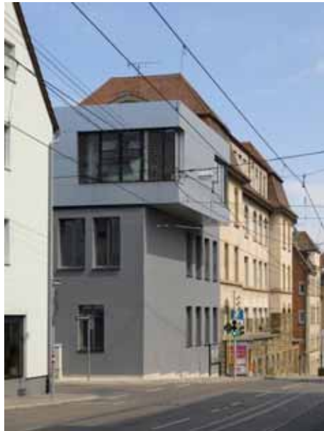
GS Gaisburg, Aufstockung Architekt: Hochbauamt Stuttgart / Gabeler
