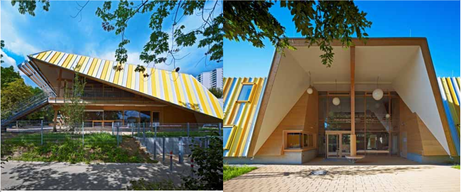
Kindertagesstätte in Stuttgart Freiberg Arch. hammeskrause
