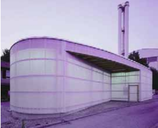
2003 Fahrzeughalle, Baubetriebsstelle Tiefbauamt Stuttgart-Feuerbach Architekt: Kamm Architekten
