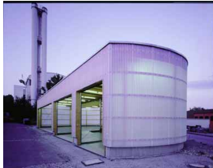
Fahrzeughalle Feuerbach Arch: Kamm Foto: C.Richter
