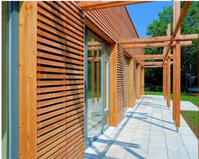
Passiv-Kindergarten Stuttgart Feuerbach Arch: Hochbauamt Foto: M.Storck
